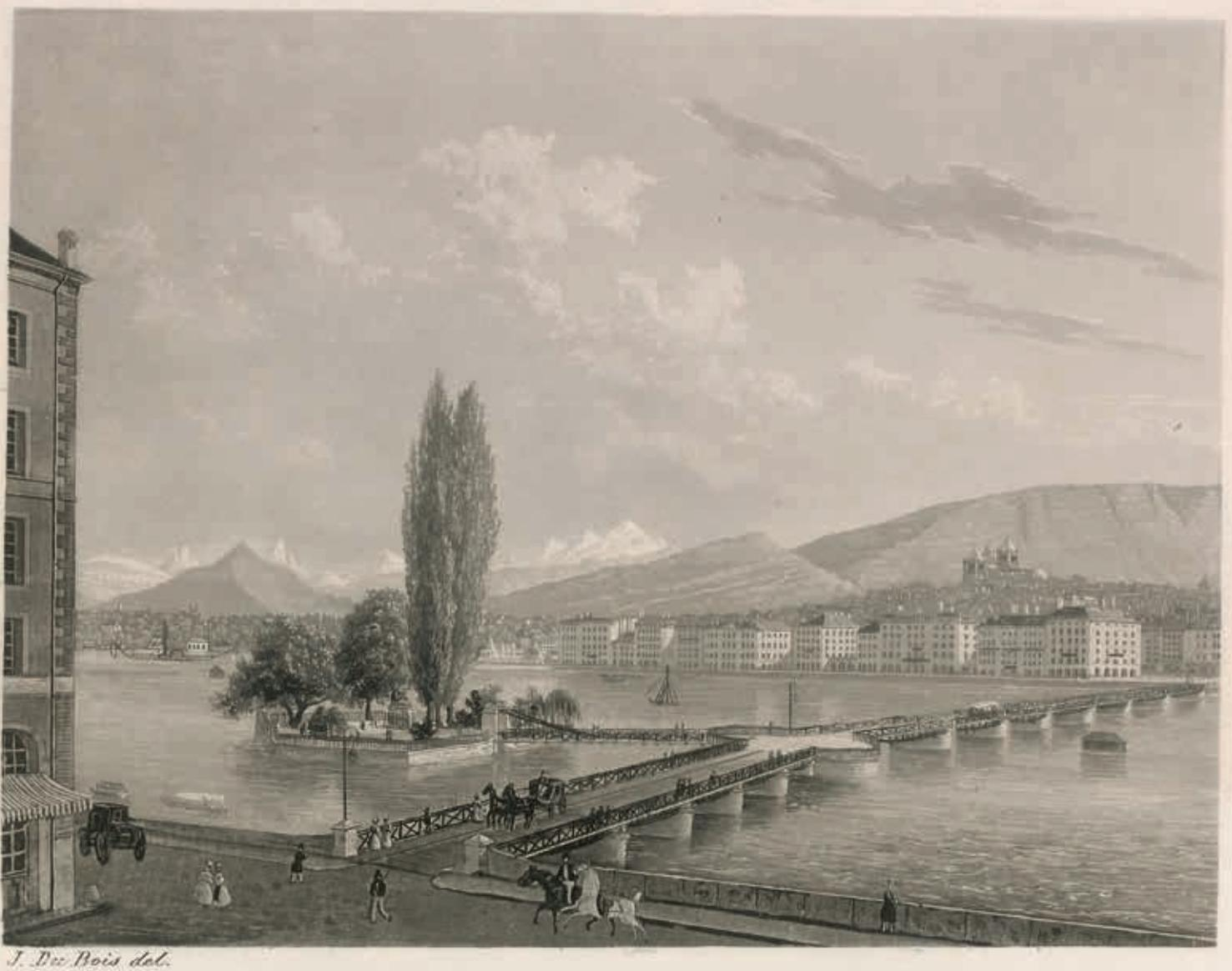
vie à une idée déjà ancienne, Dufour frappe un grand coup en réalisant avec Marc Seguin et Marc-Auguste Pictet le premier pont permanent en fil de fer construit en Europe, inventant au passage un système d'ancrage encore employé aujourd'hui pour fixer les bouts de câbles précontraints.
