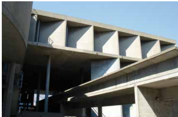
Façade du Carpenter Center for the Visual Arts, conçu en 1963 par Le Corbusier à Harvard.
