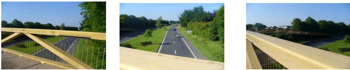
Fig 8. « D'un quartier à l'autre, la passerelle, le passage »
