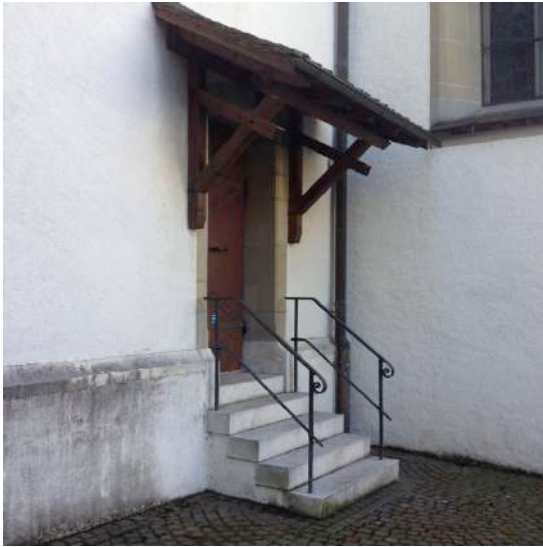
Figure 3: passage du coeur (à gauche, base en calcaire blanc) à la nef principale (façade nord-ouest); entrée latérale. La pierre ayant servi à la construction de la nef est masquée par du crépi peint en blanc.
