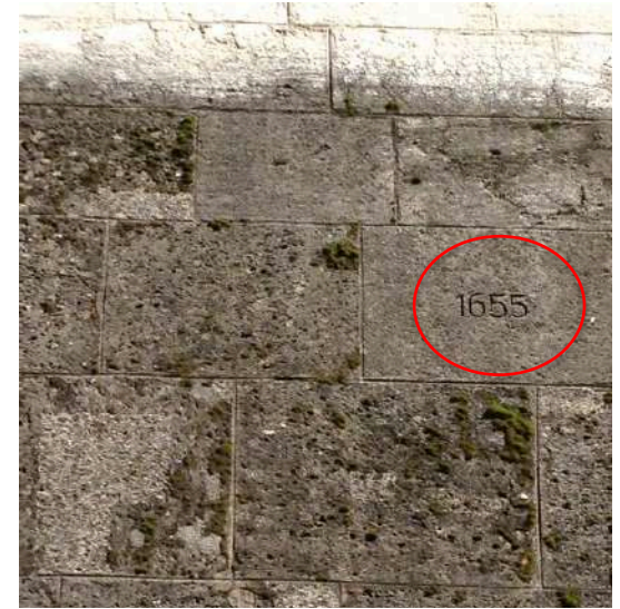
Figure 5: à droite de la plaque fig. 4, inscription dans des calcaires coquiller de Mägenwil, rappelant l'année 1655. Est-ce que cela signifierait que la base de la tour n'aurait été achevée qu'à cette date?
