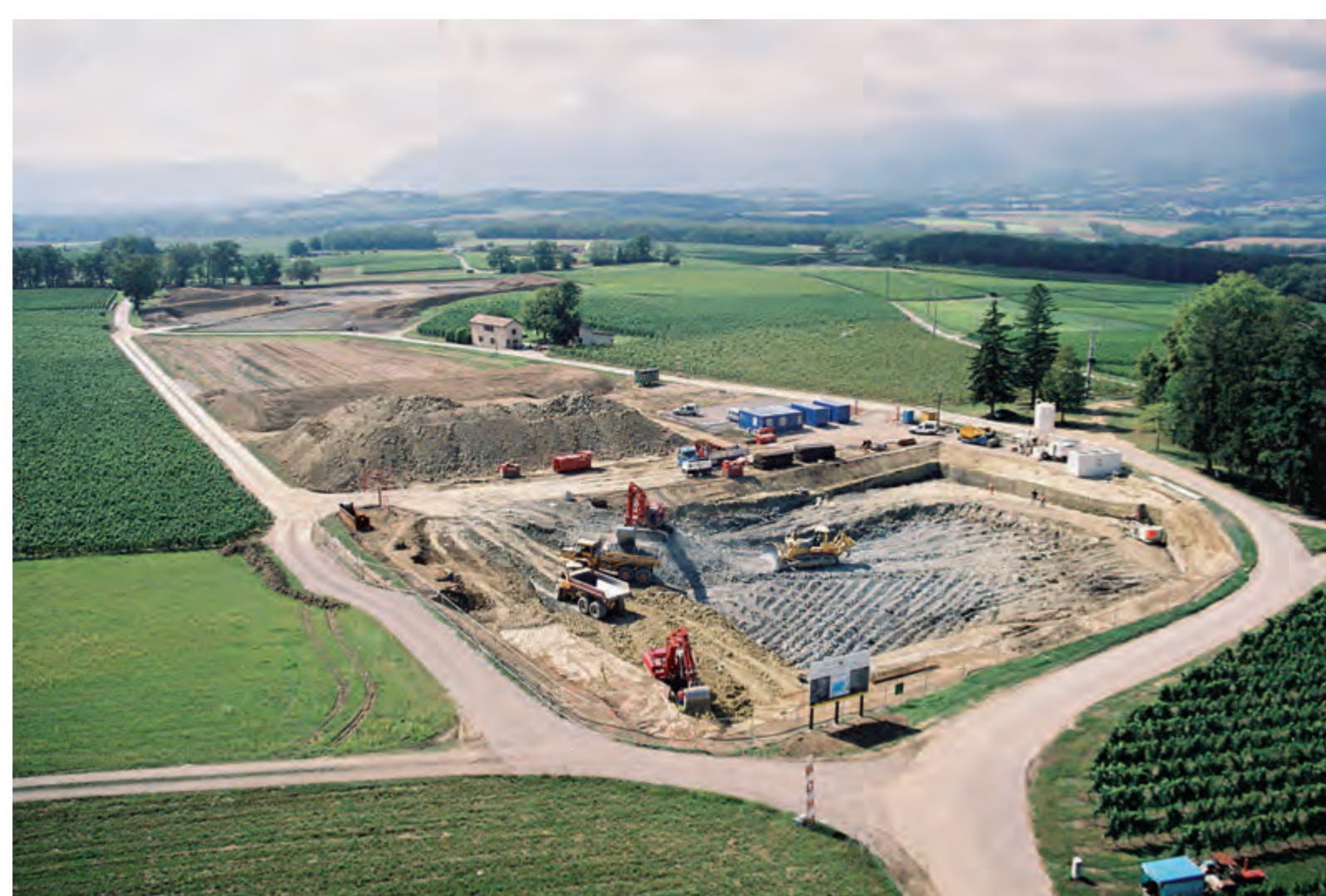
Vue générale de la zone affectée par les travaux pour le réservoir construit par les SIG, 2005.
