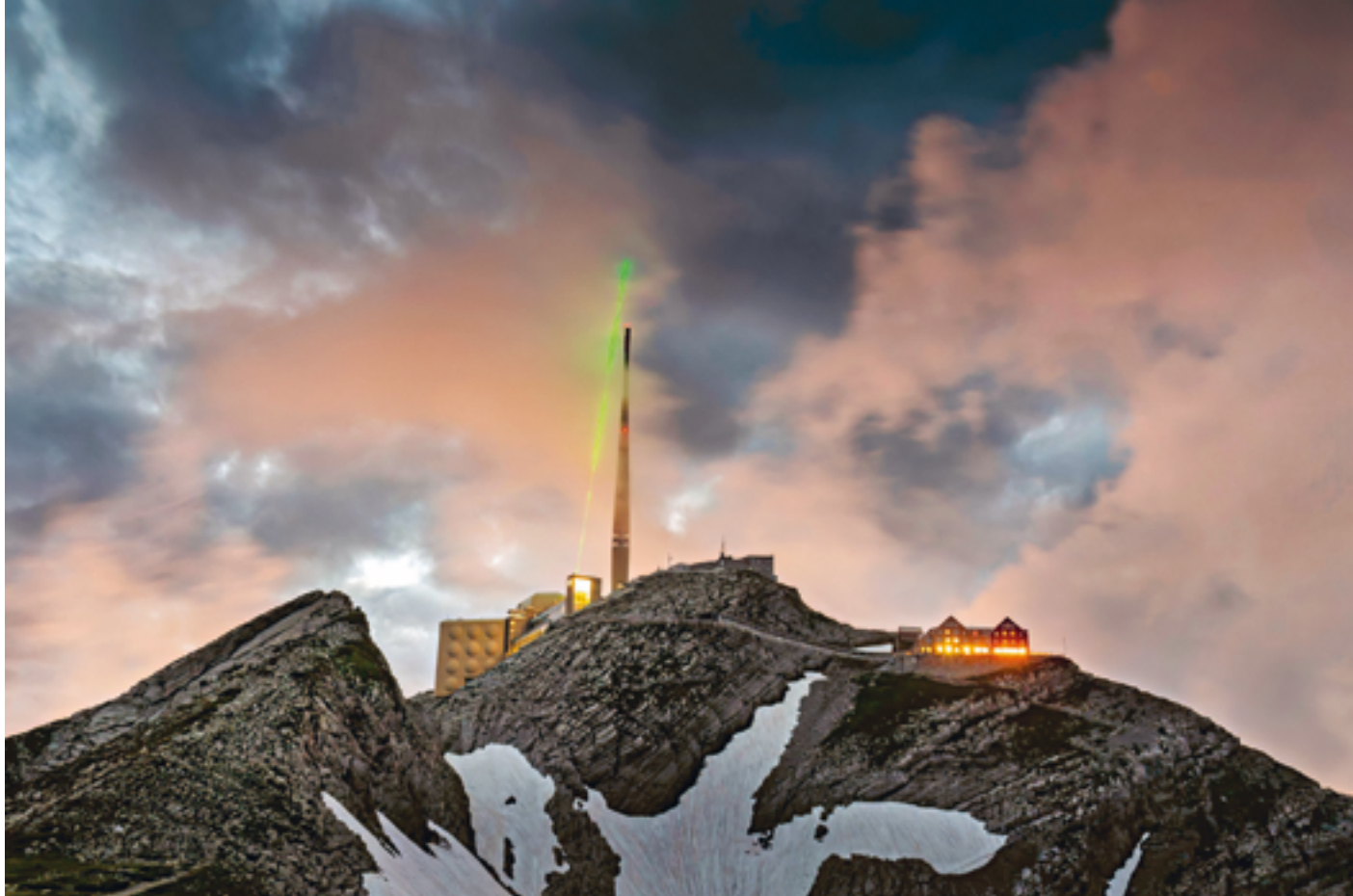
Laser installé sur le sommet du Säntis permettant de guider la foudre et d'agir comme un paratonnerre géant.
