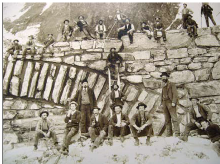
Barrages aménagés sur le torrent, plus haut dans la vallée.
