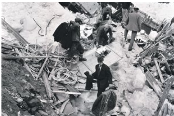
Les ruines du chantier, le lendemain de l'avalanche. Photo: Keystone
