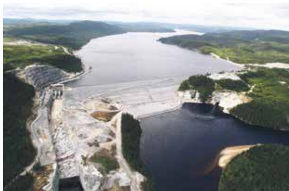
Barrage Péribonka IV, construit en 2008. Photo: DR
