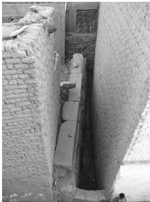
Fig. 8 : Vue du mur isolé (© Ph. Collombert)
