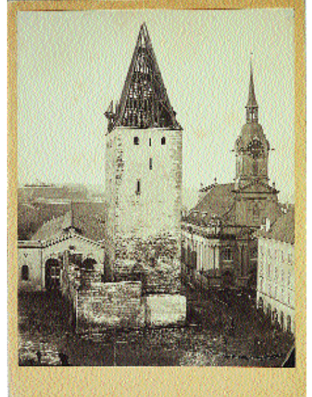
Demolition of the Christoffel Tower in Berne / albumin paper photograph / Bernisches Historisches Museum, Berne / © photo: Stefan Rebsamen, Bernisches Historisches Museum
