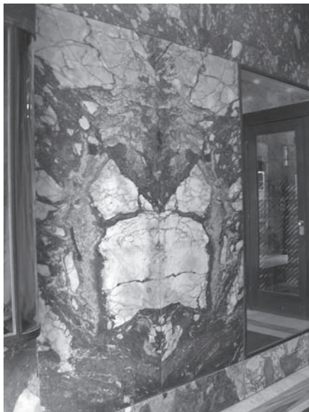
Fig. 6 : Vienne, Michaelerplatz, maison de commerce Goldman et Salatsch, 1909-1911, arch. Adolf Loos, détail du parement de marbre de l'entrée latérale.
