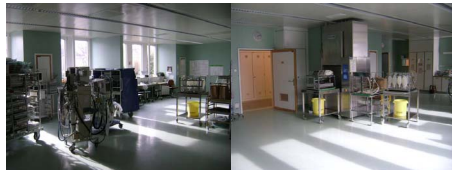
Local de décontamination à OPERA
