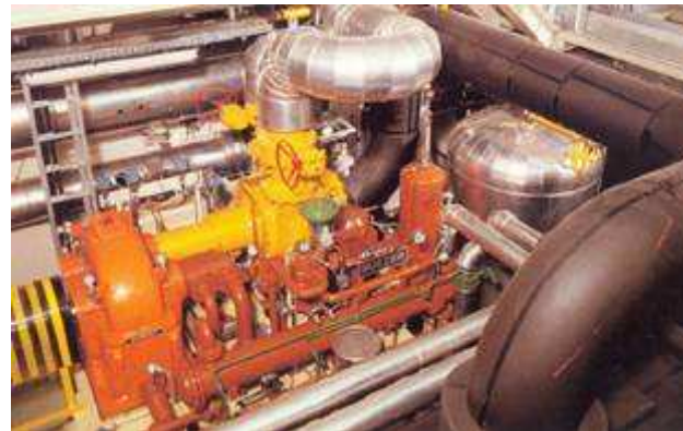
Compresseur avec multiplicateur et système d'huile
