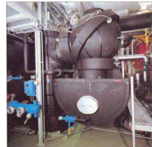
Evaporateur avec système de nettoyage des tubes à balles au dessus de la boîte à eau évaporateur
