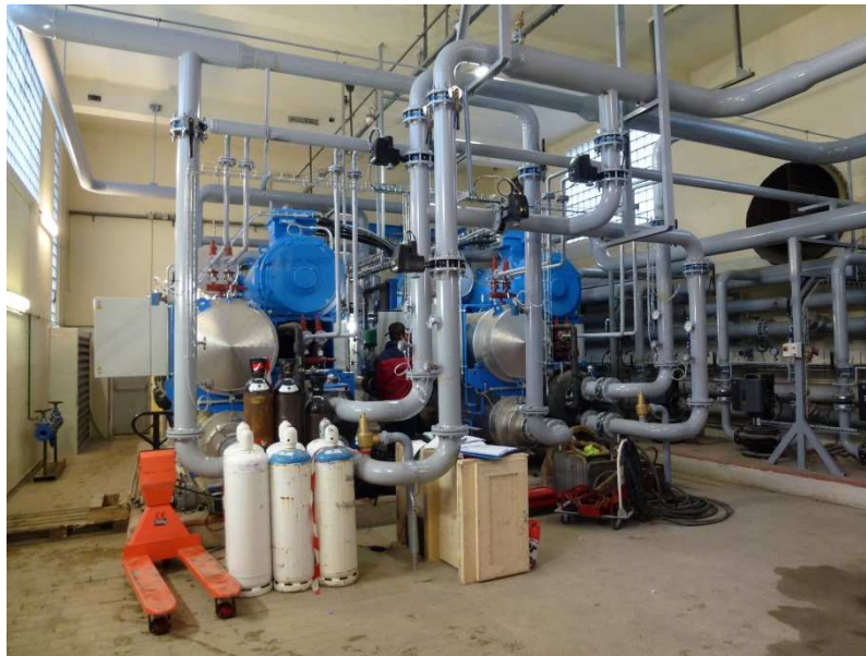
Installation des PACs sur site.
