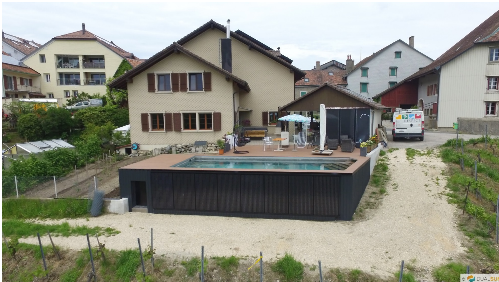
PVT pour chauffage de piscine, St Livres (Vaud)
